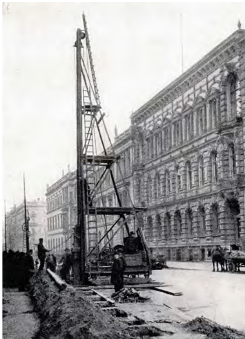
Beginn des Baus für den unterirdischen Abschnitt auf der Stammstrecke (oben) und am Leipziger Platz (rechts).
